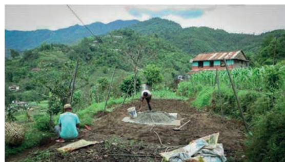
die fundamente des gewächshauses werden angelegt.
