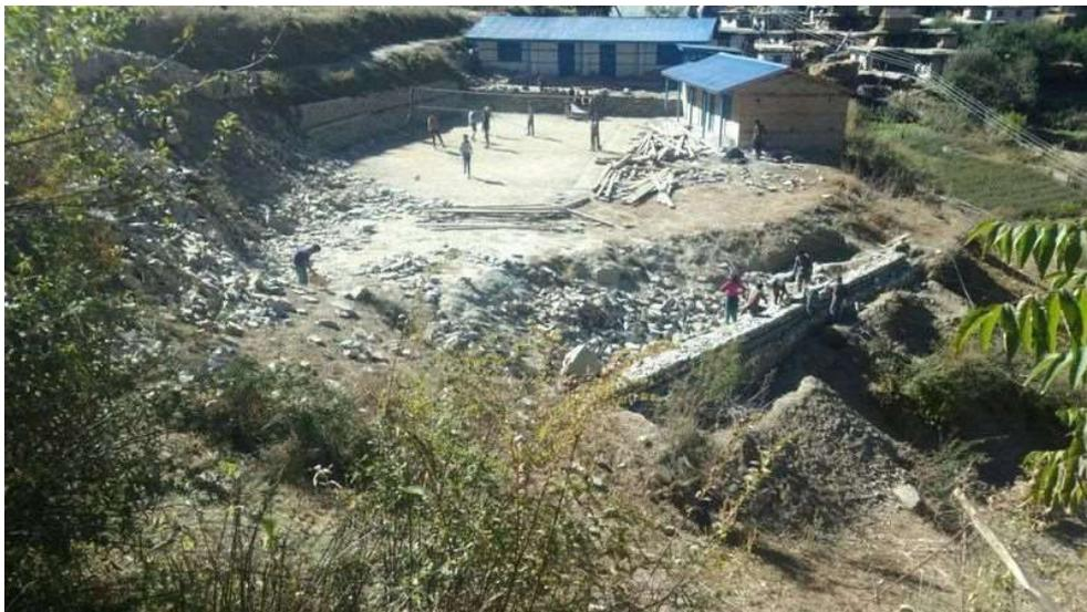
« Die Fertigstellung des Baus scheint weitere zwei Monate in Anspruch zu nehmen, da sich der Boden, der für das Gebäude angelegt wurde, als schwach erwies und er ausgegraben und mit Steinen aufgefüllt werden musste, um ein stabiles Fundament zu bilden...Es musste auch einige Zeit abgewartet werden, bis es sich gesetzt hatte. Aber seit gestern, nach Tihar, sind die Arbeiten in vollem Gange, und wir sind entschlossen, den Bau in weiteren 60 Tagen zu beenden.
